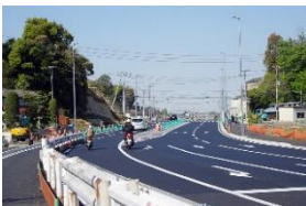
拡幅した新吉田南交差点付近
