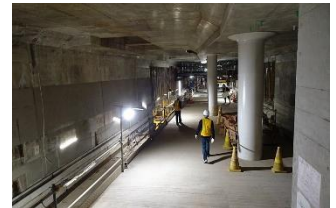
新綱島駅工事の様子(4月24日)
