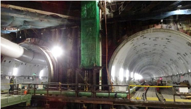
新綱島駅と箕輪町を結ぶ「綱島トンネル」工事の様子(3月末)
