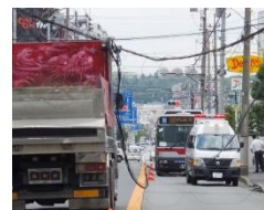
電線を切断されたことで綱島街道は通行止めに
